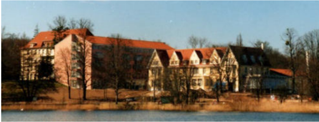
1998 | Blick über den Tiefwareensee – von links nach rechts: Haus B, Haus C, Haus E
