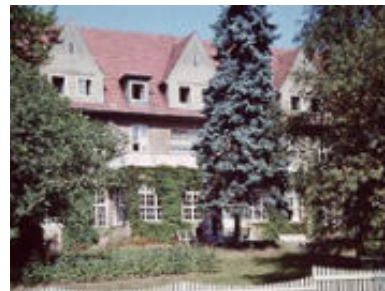
1966 | Nach Errichtung des Bettenhauses 1931 wird das einstige Haupthaus „Altbau“ genannt.
