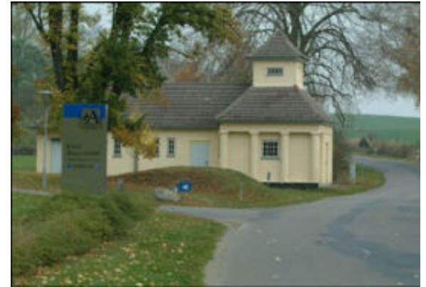
2004 | Pumpenhaus mit sanierter Fassade
