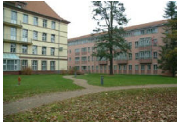
2004 | links Haus B, rechts Haus C
