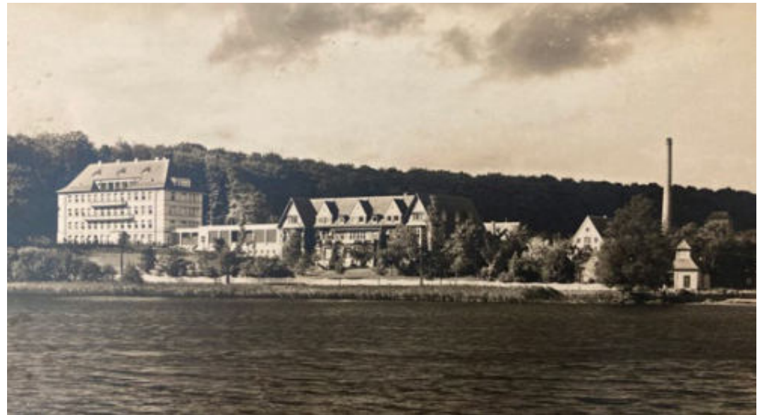
1932 | Blick über den Tiefwareensee auf den Klinik-Komplex
