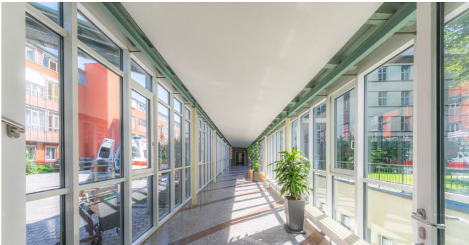
Der gläserne Gang verbindet die Häuser A und B.
